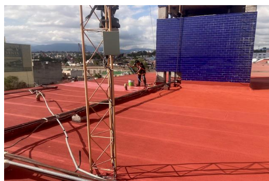
Figuras 21 y 22. Mantenimiento correctivo al impermeabilizante del edificio A
