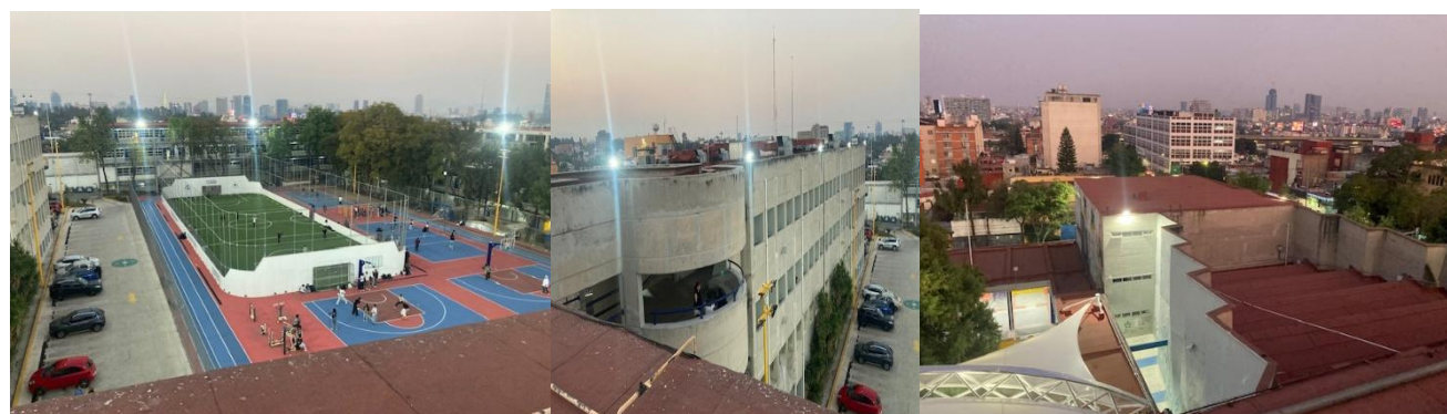
Figuras 66, 67 y 68. Instalación de reflectores de 500w y 600w
