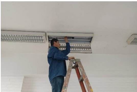
Figuras 15 y 16. Cambio de lámparas y luminarias por led en aulas, pasillos y laboratorios
