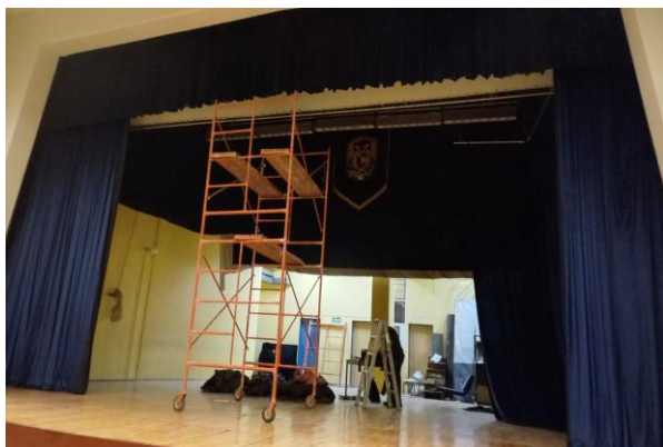
Figuras 27 y 28. Rehabilitación del telón del auditorio (cambio de manual a automático)
