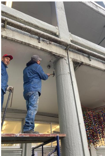
Figuras 44 y 45. Mantenimiento de bajadas de agua pluvial en edificios A y B
