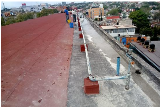
Figuras 21 y 22. Mantenimiento correctivo al impermeabilizante del edificio A
