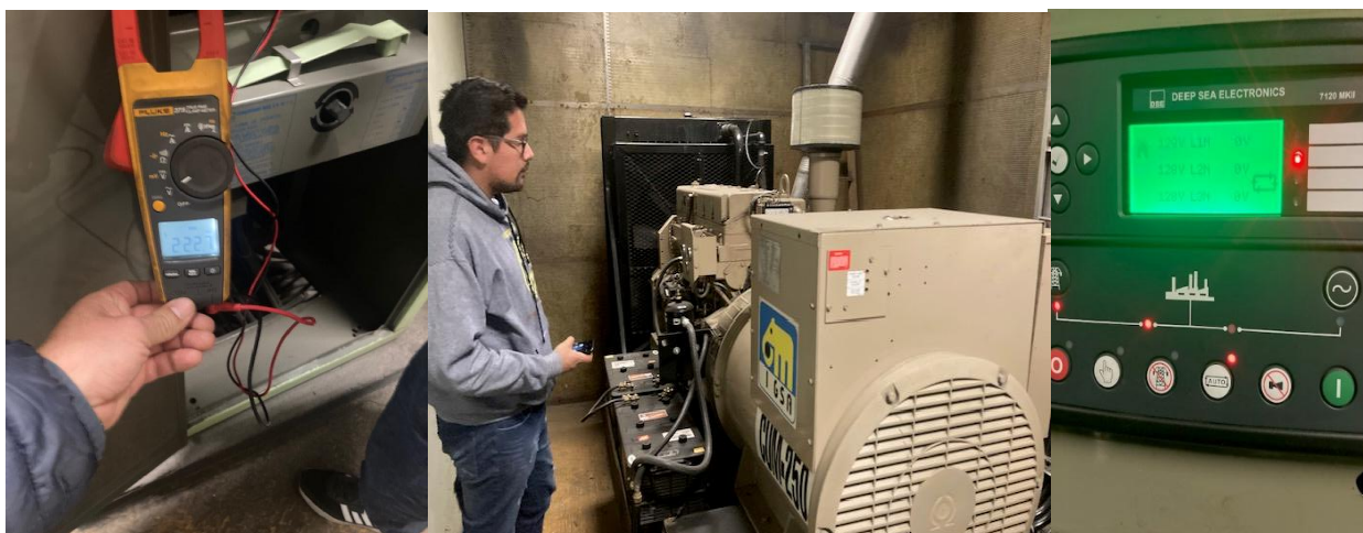
Figura 50, 51 y 52. Puesta a punto de la planta de emergencia
