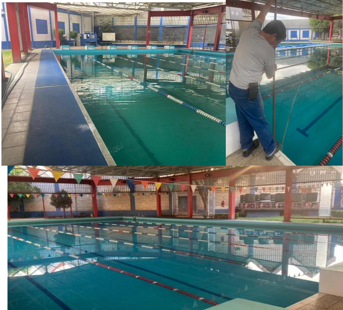
Figuras 57, 58 y 59. Mantenimiento de la alberca
