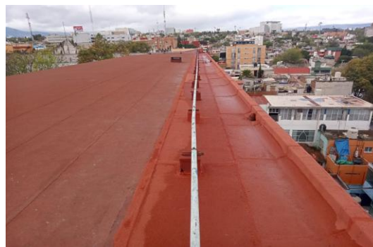
Figuras 21 y 22. Mantenimiento correctivo al impermeabilizante del edificio A
