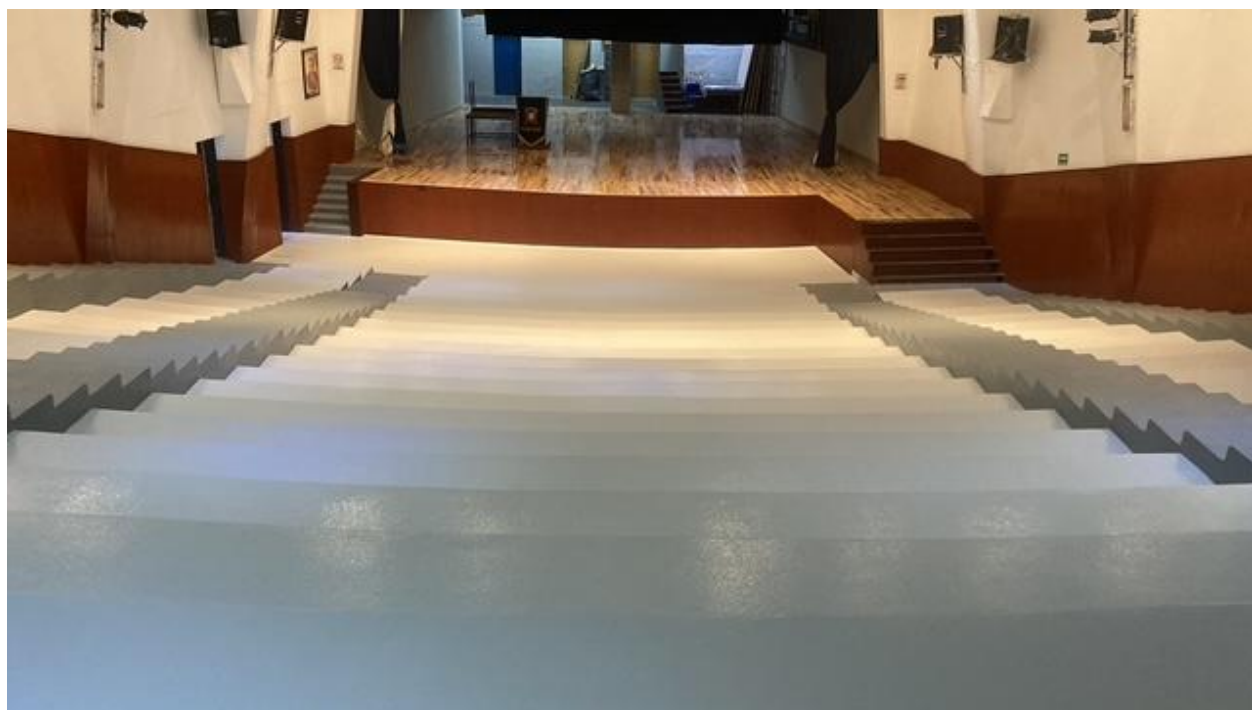
Figuras 76 y 77. Mantenimiento. correctivo a piso del aforo del auditorio
