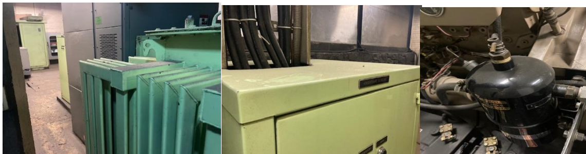
Figuras 44, 45 y 46. Mantenimiento a subestación eléctrica y planta de emergencia
