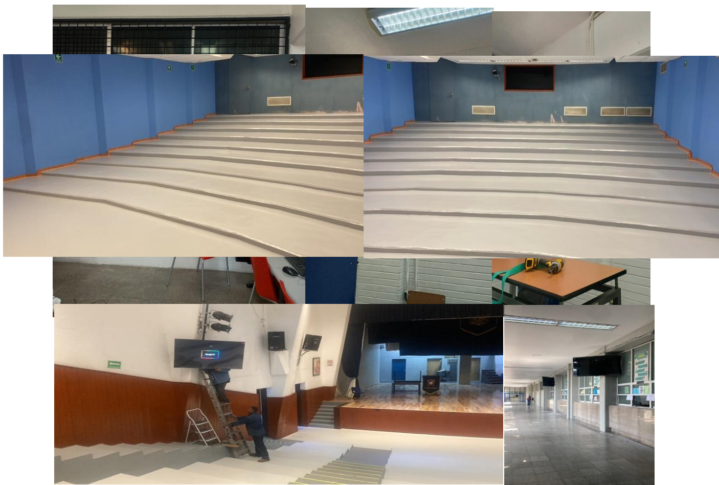
Figura 75. Mantenimiento correctivo al piso de la sala Martínez y Martínez
