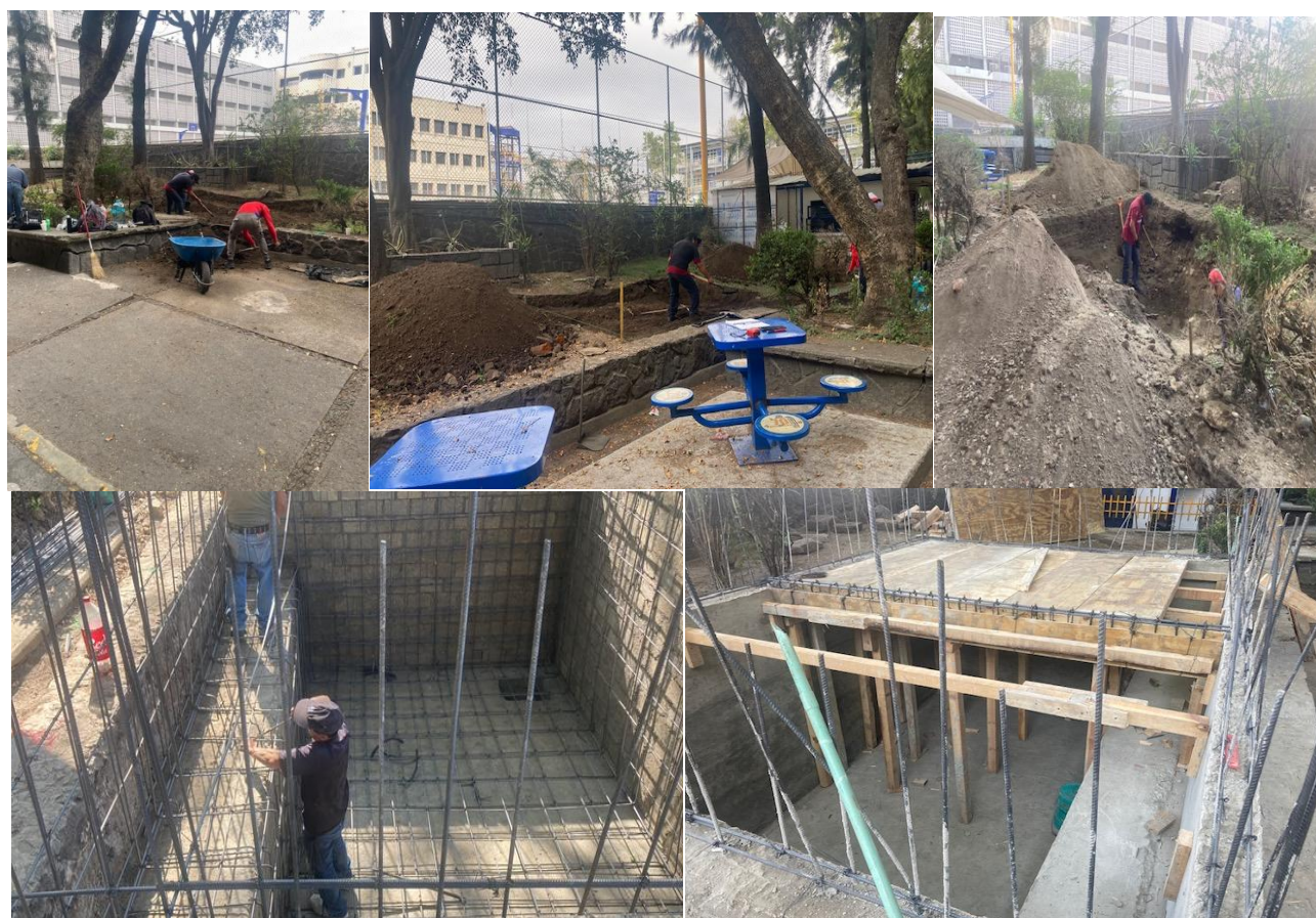
Figuras 60, 61, 62, 64 y 65. Realización de cisterna para captación de agua pluvial en canchas deportivas
