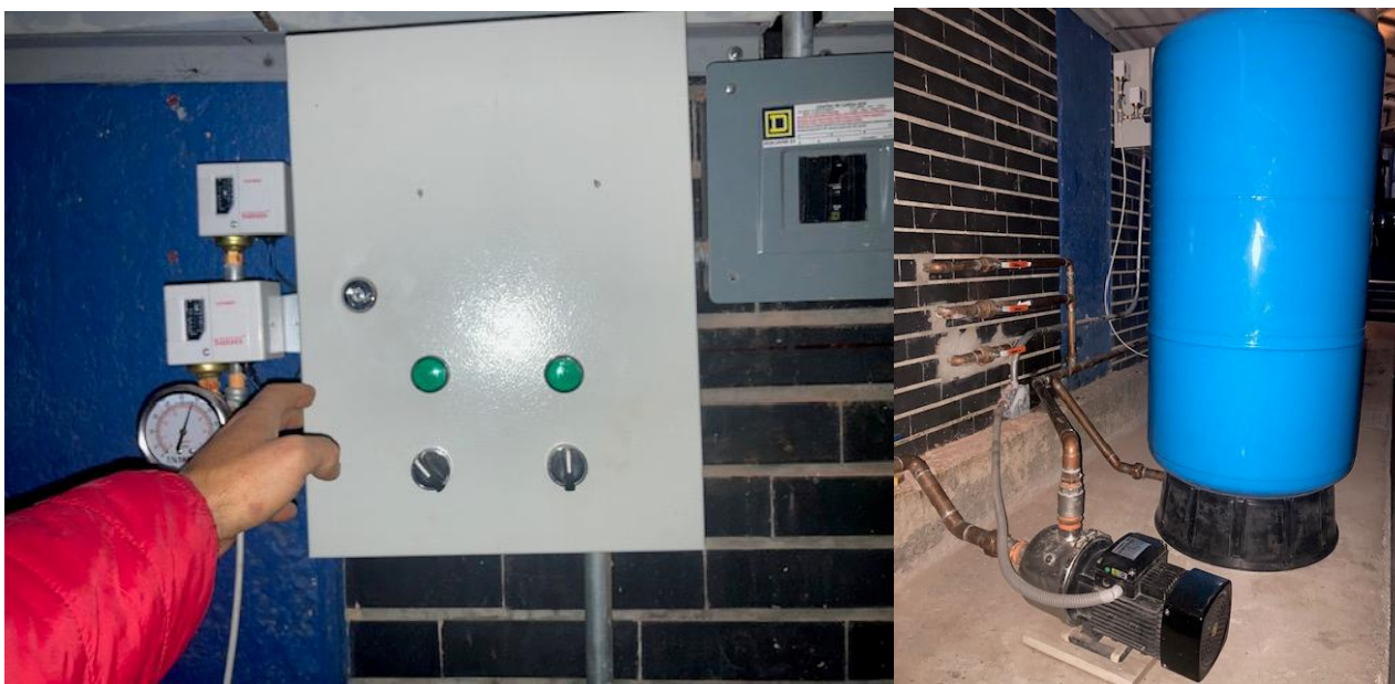
Figuras 53 y 54. Mantenimiento preventivo a equipos hidroneumáticos
